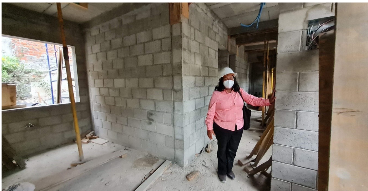
2. Paula Bernal, cooperativista de vivienda asociada a ACOVIAMFU, en una de las viviendas que están siendo construidas en el Centro Histórico de San Salvador, con fondos del programa estatal. Febrero 2022. Fuente: Natalia Quiñónez.
