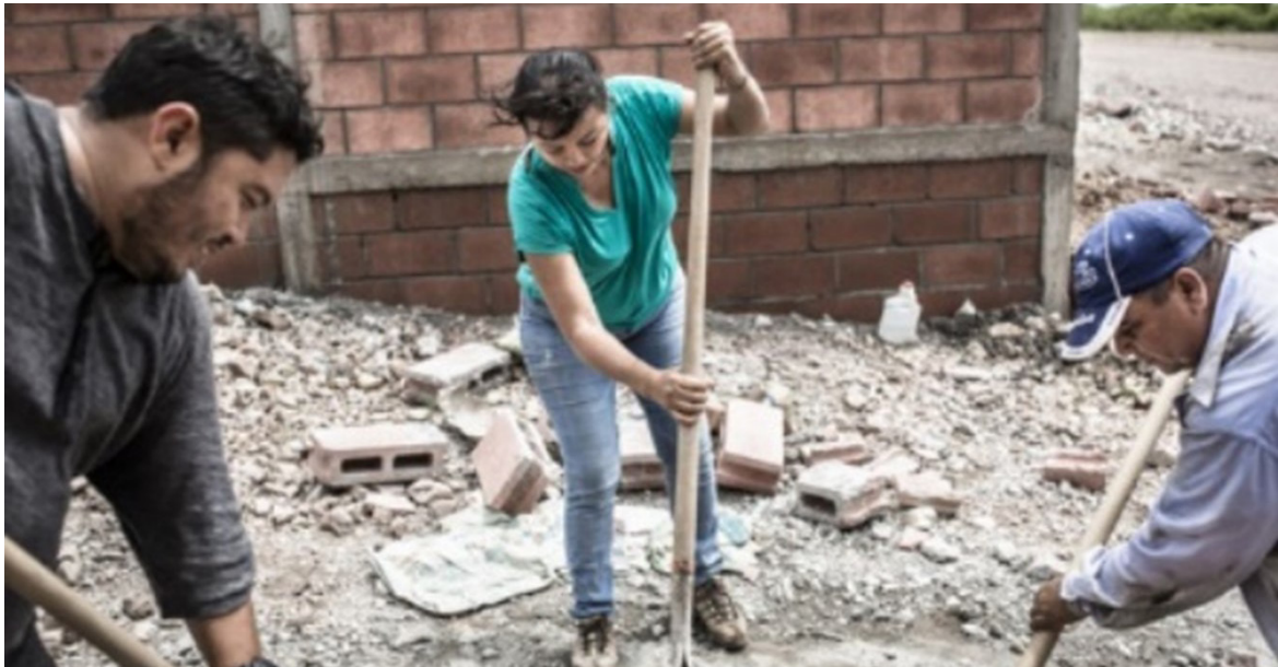
4. Cooperativistas de vivienda en etapa de construcción del complejo habitacional de la cooperativa de vivienda COVIMARL, en el sur de Honduras. Año 2014. Fuente: We Effect América Latina.
